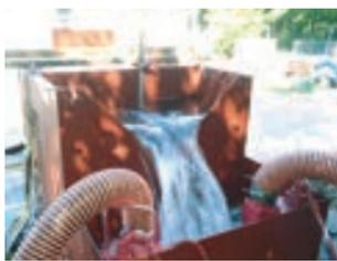
掘った穴にポンプをいれて水が安定して出ることを確認し、飲み水に適しているかどうかの水質検査をします。
